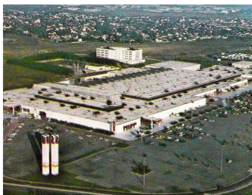
Centre Cal du Mont Gaillard au Havre
