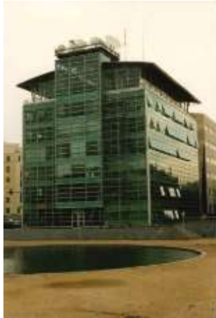
Immeuble de la tête de réseau Citévision de Saint Quentin en Yvelines
